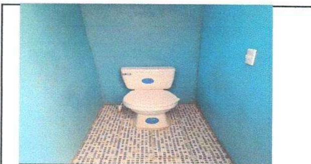
Foto 5: Sustitución de taza o inodoro
