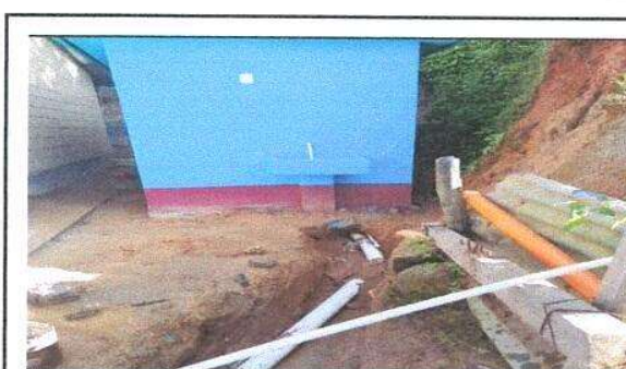
Foto 6: Sustitución de tubería de pvc
