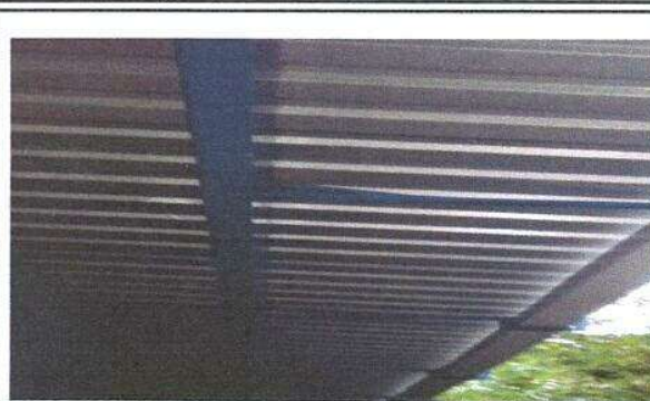
Foto 2: Sustitución de soporte de metal
