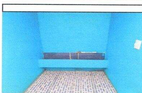
Foto 4: Sustitución de piso de concreto
